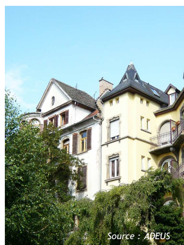
Immeubles XIXe, rue des Foulons
