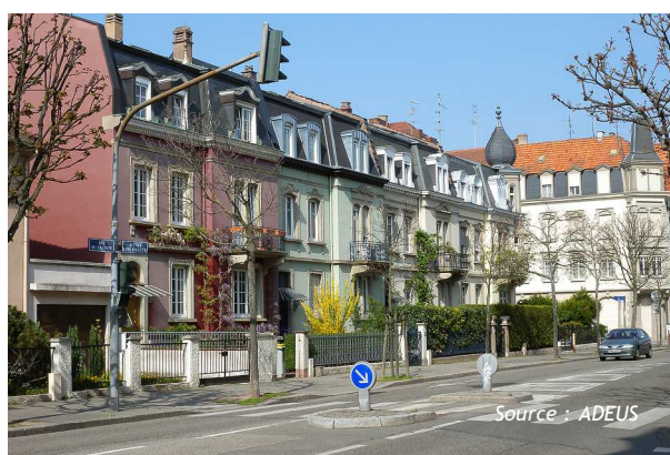
Maisons de ville, av. L. Dacheux, Neudorf
