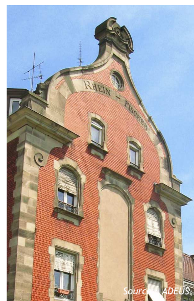
Le Châtelet Fischer, rue du Péage
