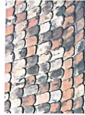
Couverture à simple recouvrement
