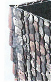
Couverture à double recouvrement
