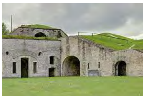
Le fort militaire de Beauregard à Longvic et Fény, bâti en 1887, dont la valeur est à affirmer à travers l'implantation potentielle de nouveaux usages
