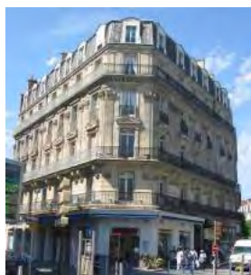
Immeuble de type haussmannien
