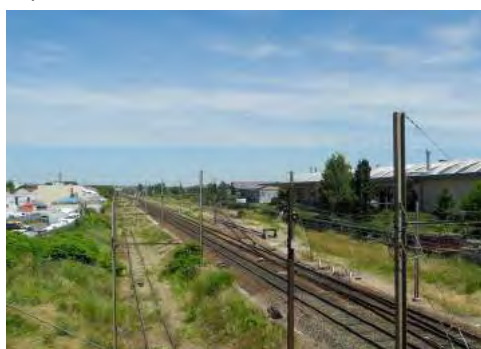
Les talus ferroviaires, espaces de circulation de la biodiversité
