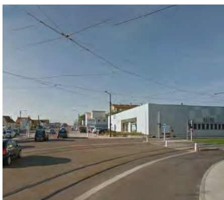
Entre Dijon et Chenôve - Fin de la requalification liée au tram
