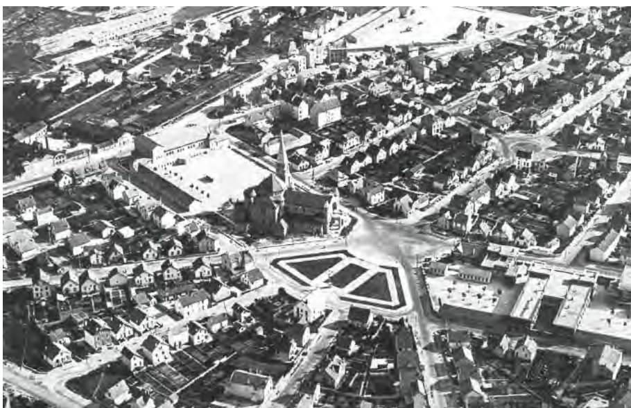
Le quartier de la Maladière, un tissu urbain structuré organisé en grands îlots et bénéficiant dès l'origine d'équipements de proximité
