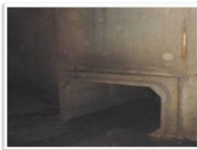
Bassin enterré Bailly à Dijon – arrivée effluent
