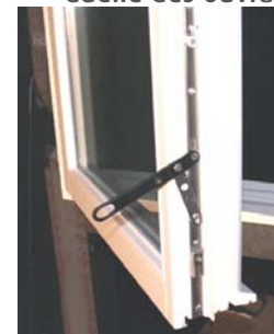
④ Fermeture individuelle des ouvrants
