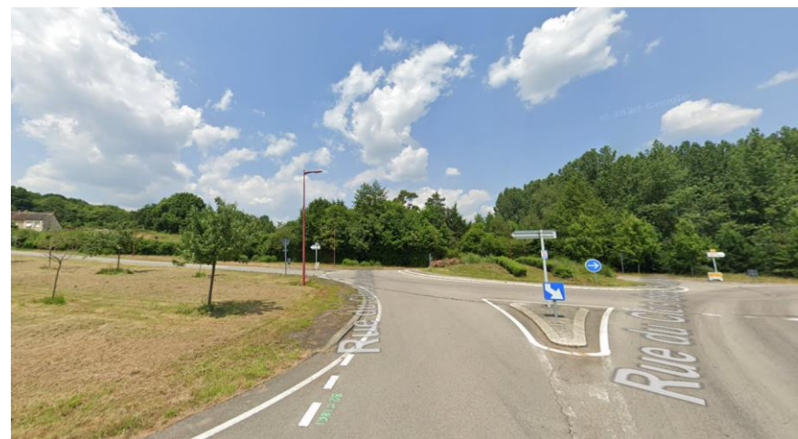
Vue depuis le site ©GoogleStreetview
