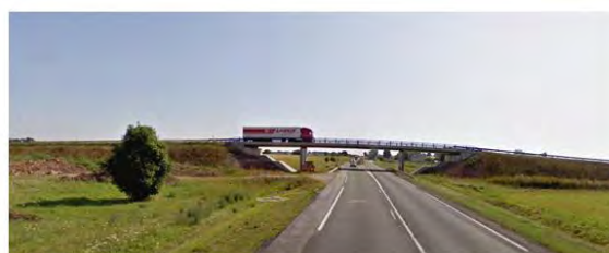
RN12, vue depuis l'échangeur en direction d'Alençon
