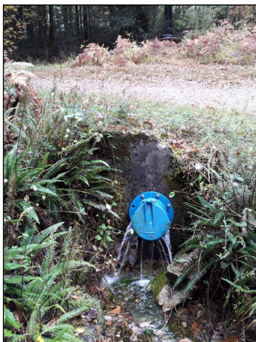
Trop plein le 27/10/2020 Puits à l'arrière-plan
