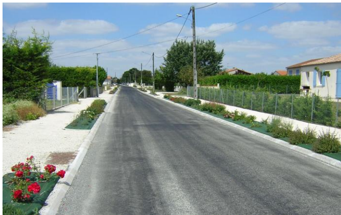
Urbanisation linéaire et réaménagement de la rue de Prérour.
