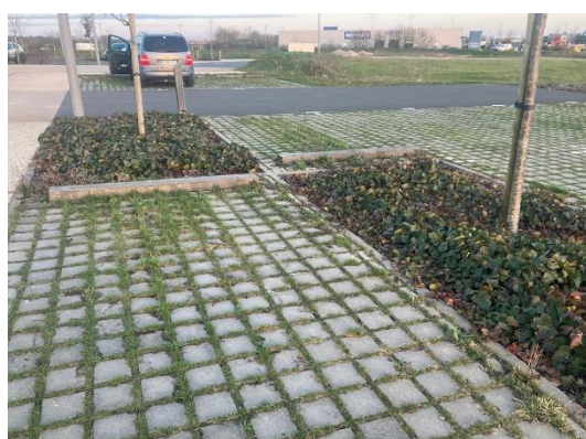
Exemple de parking paysager et poreux avec dalles gazon et bandes enherbées (infiltration des eaux)
