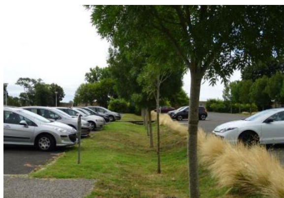
Bande paysagère faisant également office de noue (gestion des eaux de pluie) plantée d'un alignement d'arbres en accompagnement d'un parking. Les espaces bitumés ne menacent pas la croissance des arbres.
