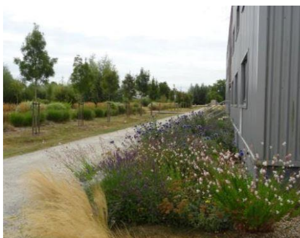
Espace planté en pied de mur ayant un rôle d'infiltration des eaux de pluie de la toiture
