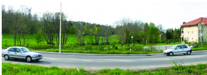
En continuité directe avec le bourg de Meximieux, Rémillieux s'inscrit dans une dynamique routière et commerciale, déconnecté de l'espace rural qui transparait en arrière plan
