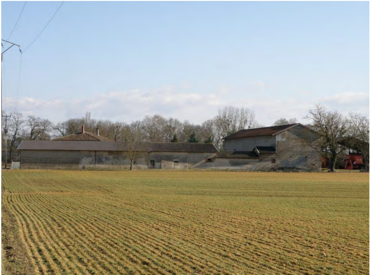
A. Ensemble bâti de la Grange Cochet
