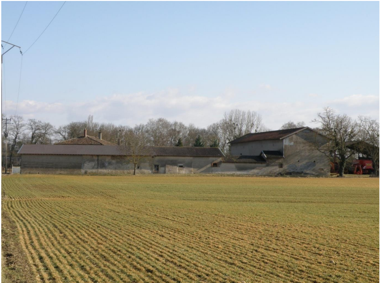
A. Ensemble bâti de la Grange Cochet
