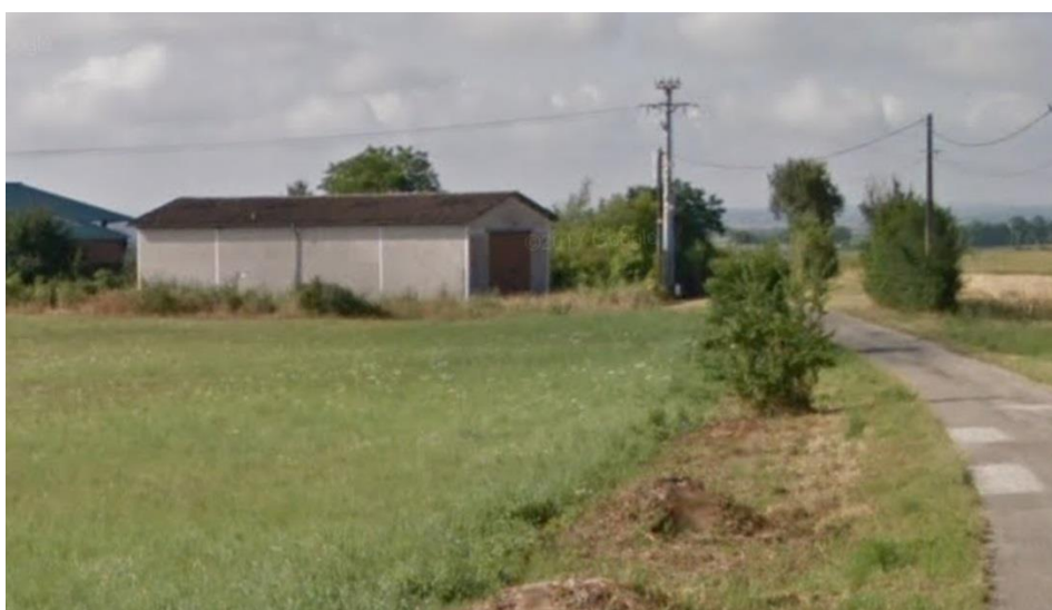
Figure 16. photo du bâtiment concerné. Source 2BR
