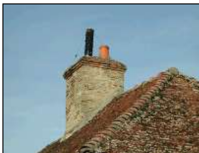
Cheminée massive en plaquettes de briques
