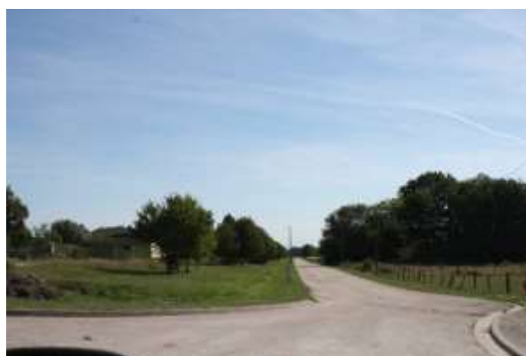
Voie de desserte le long de la voie ferrée
