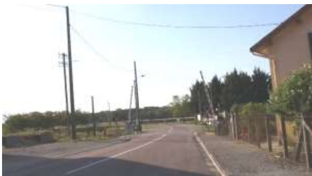
Passage à niveau pour franchir la voie ferrée
