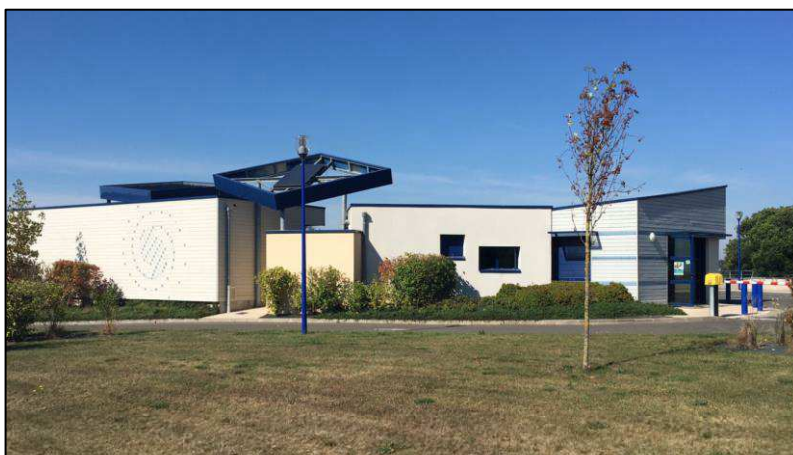
Le site de la déchetterie : source commune
