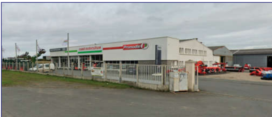
Ploufragan - RD 790 - Enseignes sur façade légales - Enseignes scellées au sol en surnombre illégales
