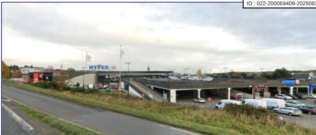
Yffiniac - RN 12 - Enseigne sur toiture légale
