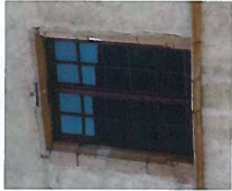
Menuiseries avec proportions de carreaux adéquates à la forme des baies
