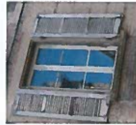
Menuiseries avec proportions de carreaux adéquates à la forme des baies
