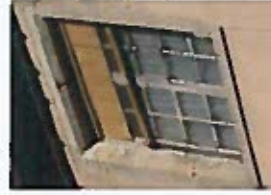
Menuiseries avec proportions de carreaux adéquates à la forme des baies
