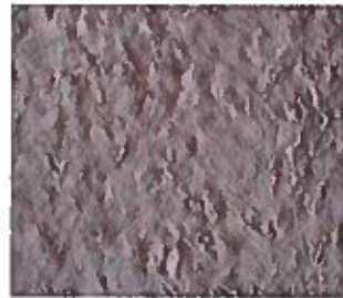
enduit jetée à la truelle
