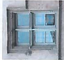
Menuiseries avec proportions de carreaux adéquates à la forme des baies
