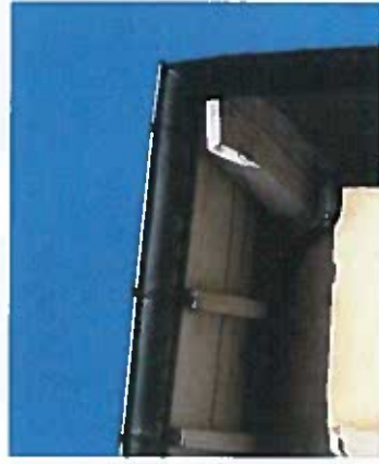
Dépassée de toiture solives et volige apparentes
