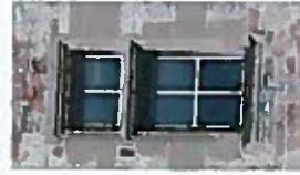
Menuiseries avec proportions de carreaux adéquates à la forme des baies
