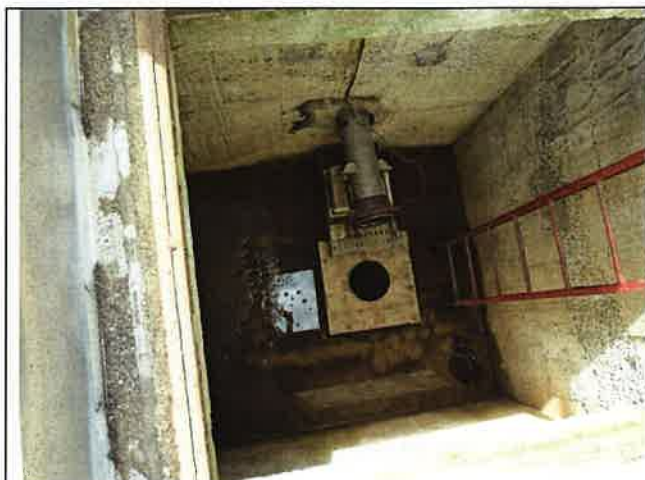
Photo 7 : Vue de l'intérieur de l'ouvrage F1
