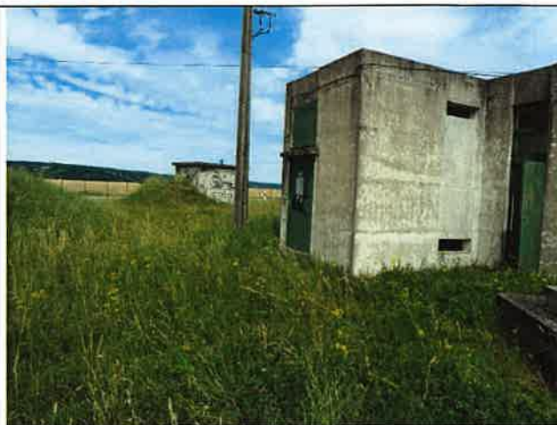
Photo 8 : Vue du local de l'ancien transformateur EDF ; au second plan, l'ouvrage F3
