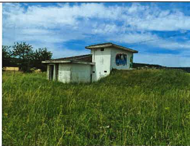
Photo 10 : Vue du bâtiment contenant la station de pompage et la bâche de reprise.
