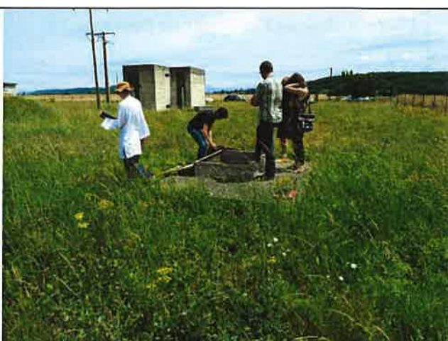
Photo 4 : Vue de l'ouvrage F2
