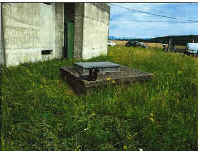
Photo 6 : Vue de l'ouvrage F1
