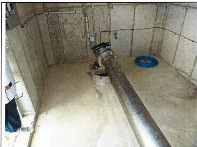
Photo 9 : Vue de l'intérieur de l'ouvrage F3
