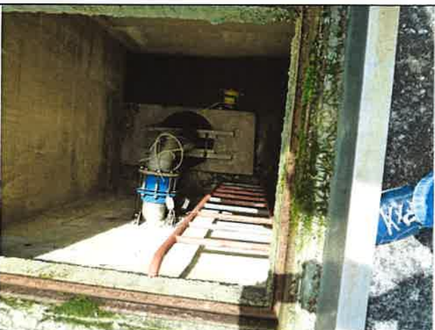
Photo 5 : Vue de l'intérieur de l'ouvrage F2
