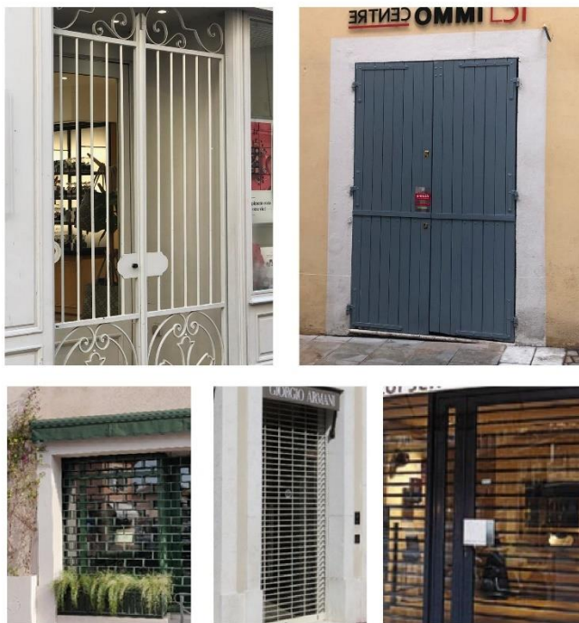
Exemples de devantures qui ont la forme de la baie et installés au nu intérieur du mur.
