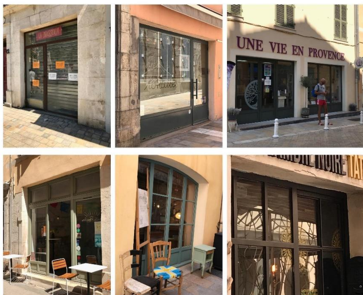
Exemples de devantures qui ont la forme de la baie et installés au nu intérieur du mur.
