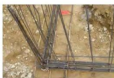
Nœud de chaînage - Continuité mécanique
