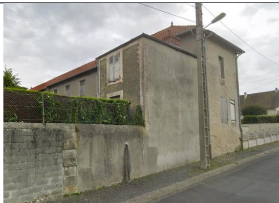
Bâtiment à détruire
