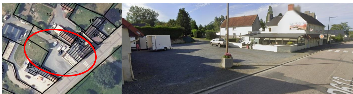
Localisation et vue sur le projet
