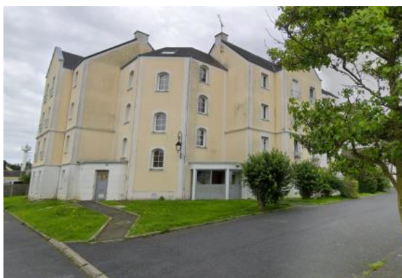
Présence d'un immeuble à 4 niveaux à proximité du projet
