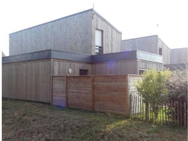
Pare-vue au droit des habitations
