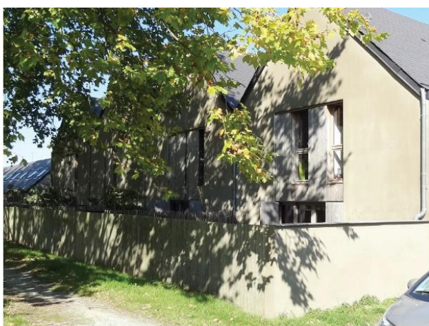
Mur de clôture en limite d'opération
