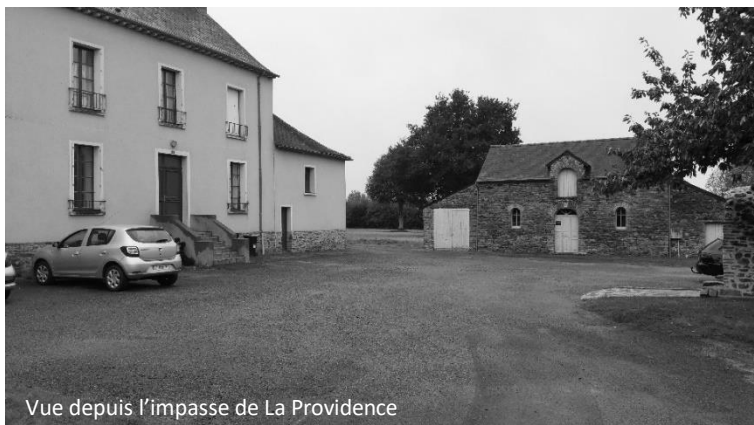
Vue depuis le Nord-Est du site
