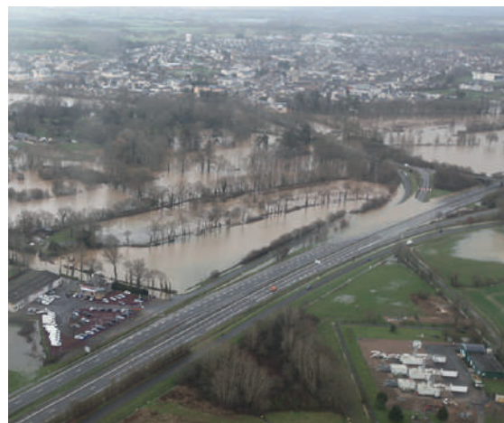
Inondation de février 2014 : la Vilaine sort du lit mineur et la RN24 est coupée à hauteur de Mordelles
