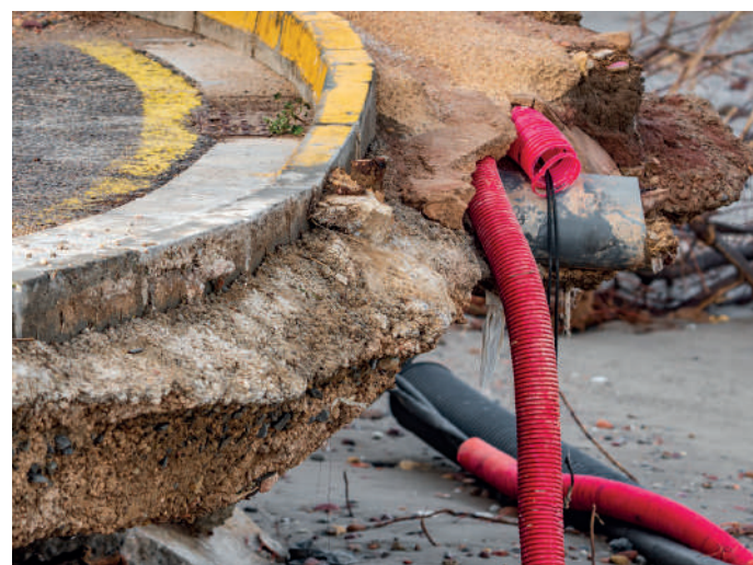
Endommagement des routes et des réseaux suite à un séisme
