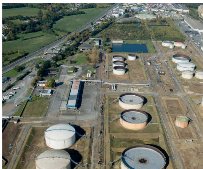
Site de Vern-sur-Seiche vu du ciel : unité de stockage et de distribution
