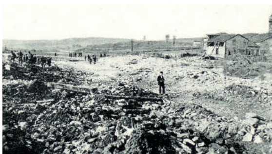
Domages suite à la rupture du barrage de Bouzey © Photo VM/DR
