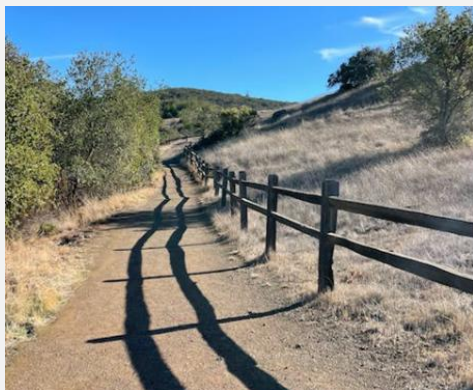
(3) Clôture à poteaux espacés
