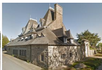
Ancien logis (Plédran)
