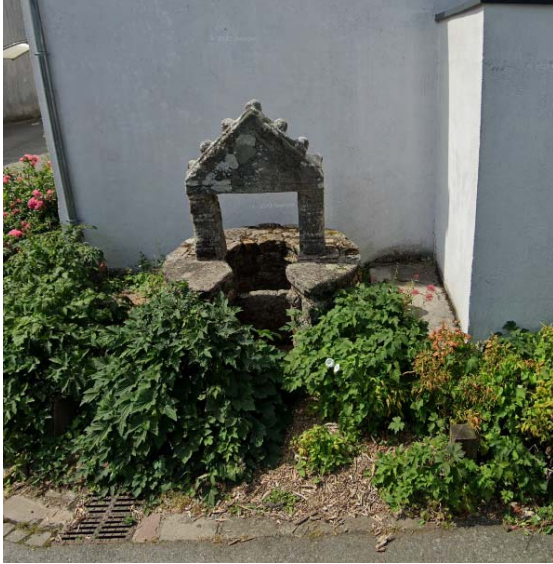
Puit Place du Centre Bourg AB 112
