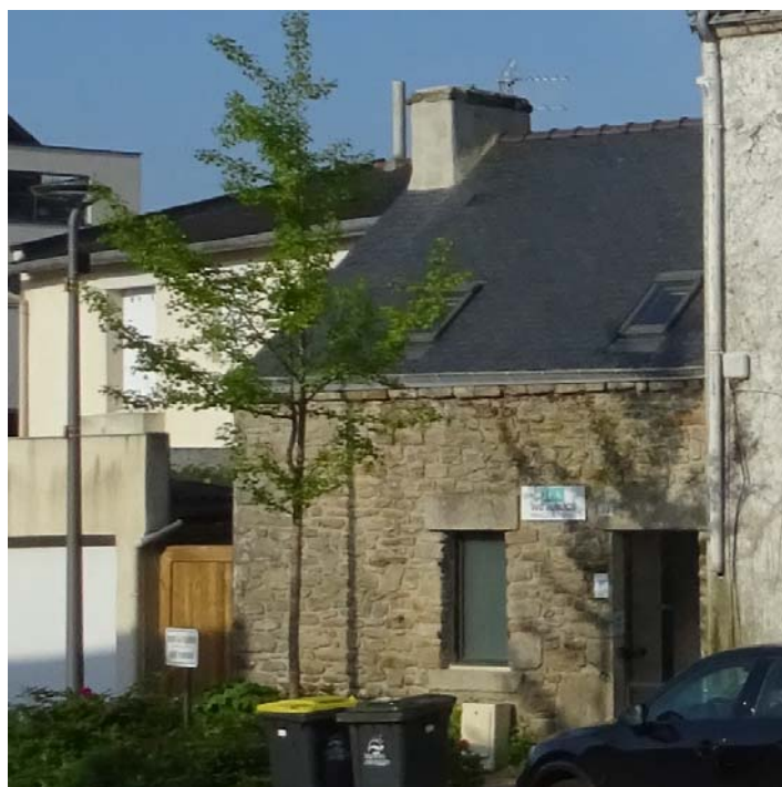
AE n°32 – rte de Ploeren (toilettes publiques)
