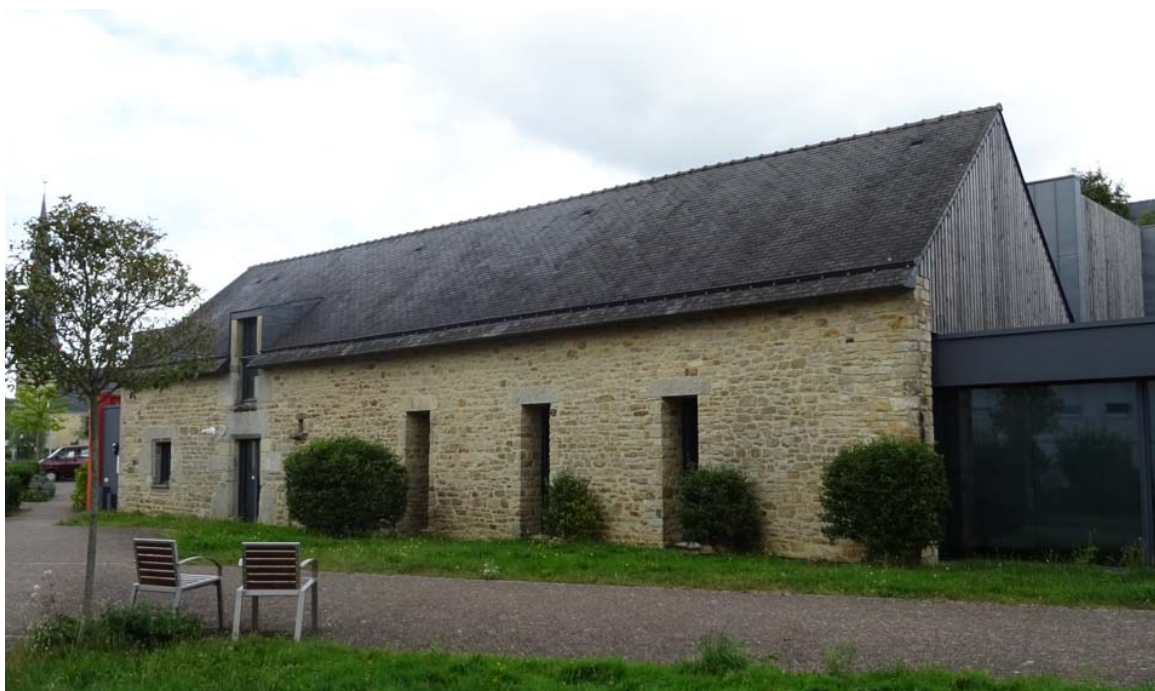
AD n°227 – Bâtiment en pierres de la médiathèque
