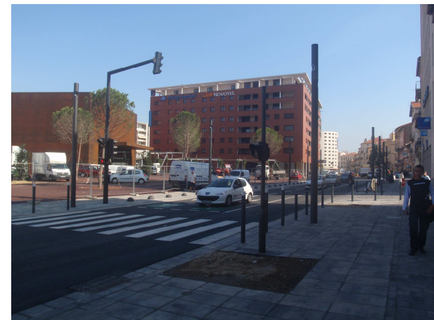
Avenue Leclerc en cours de chantier
