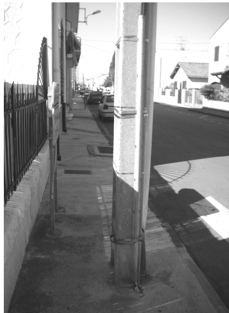
Trottoir étroit et support de réseaux aériens
