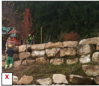
Enrochement de type cyclopéen
