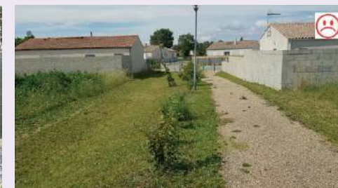
Mur en parpaing brut : un élément perturbateur. La clôture participe à la qualité des espaces communs. Une clôture qui n'est pas finie ou mal choisie peut altérer fortement la qualité d'un quartier.
