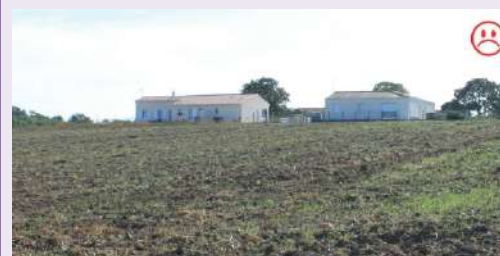
Construction générant un effet d'intrusion dans l'espace agricole : La clôture n'est pas obligatoire mais une clôture végétalisée permet notamment de protéger vis à vis des terrains cultivés et facilite l'insertion paysagère des constructions.
