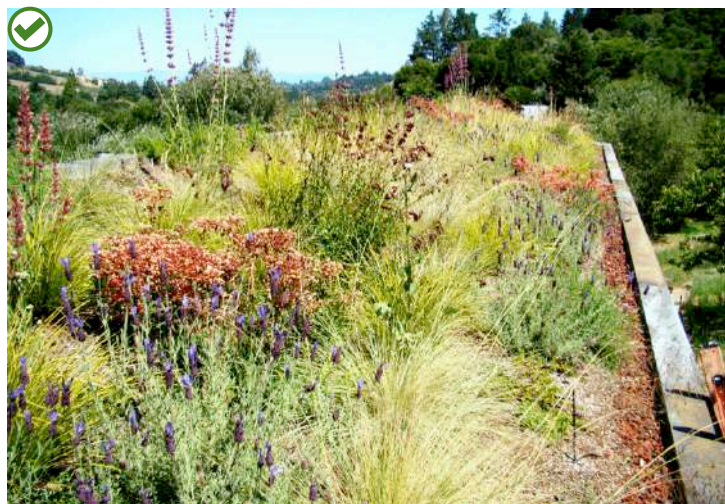
Toiture plantée - substrat 15 à 25 cm
