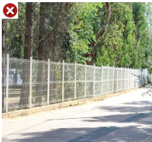
Clôture grillagée normalisée blanche
