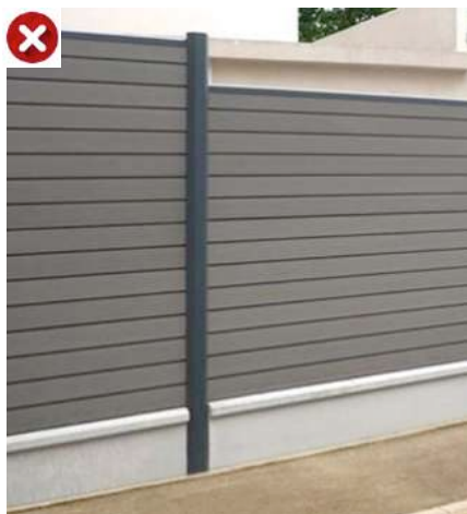
Panneaux soudés sur mur maçonné
