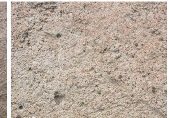
Finition grattée, avec sable à grains grossiers
