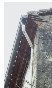
La gouttière adaptée au débord de toit et aux génoises est inesthétique au même titre que les descentes d'eau.
