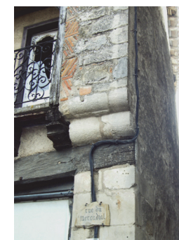
Chaînage d'angle en pierre.
