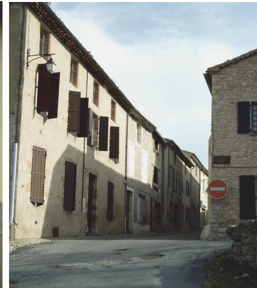
Rue de Lengouzy et ses façades XIX e
