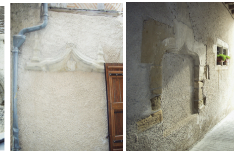
Portes et fenêtres en arc à accolade, murées
