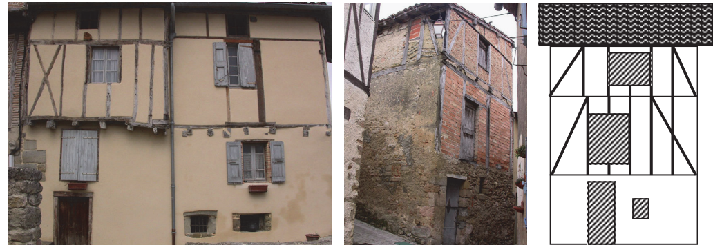
La façade n'est pas ordonnancée, il n'y a aucune symétrie, les baies semblent placées aléatoirement.
