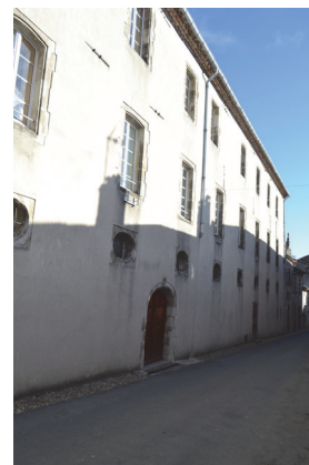
Rue en enrobé (rue du Mercadial)
