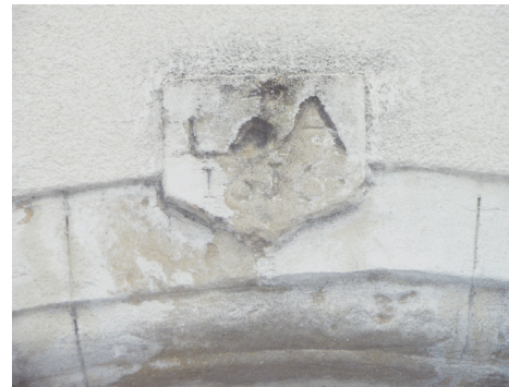
Linteau portant des initiales
