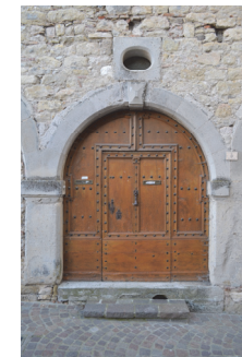
Portes cintrées à encadrement de pierres
