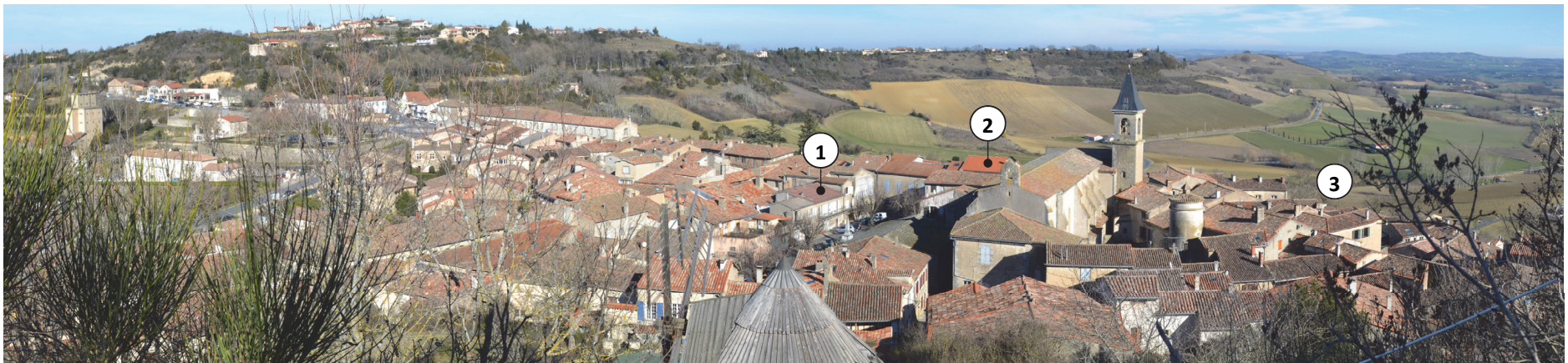
Les toits de Lautrec et les nuances dans les couvertures, vus depuis le calvaire : les toits en éverite (1) ou en tuiles mécaniques (2) déprécient l'harmonie d'ensemble des couvertures et rompent avec l'harmonie des teintes de toits en tuiles canal, comme ceux visibles dans le quartier du Mallegou (3).
