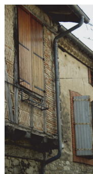
La gouttière adaptée au débord de toit et aux génoises est inesthétique au même titre que les descentes d'eau.
