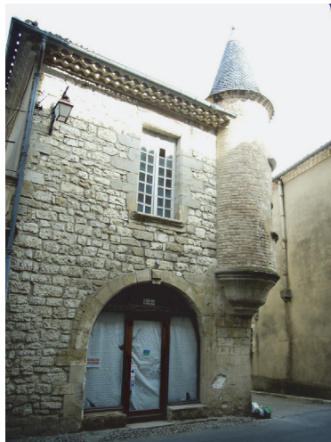
La maison Ginestet, rue Langouzy
