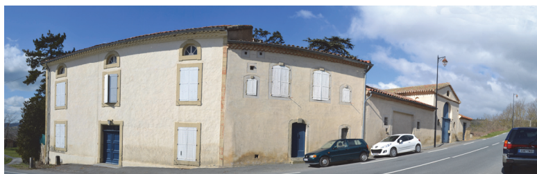
Corps de ferme 19ème siècle au Sud-Ouest du bourg ancien, route de Castres
