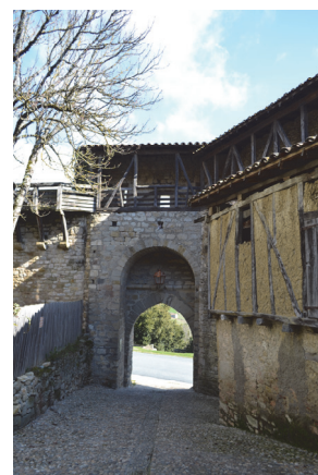
Porte de la Caussade
