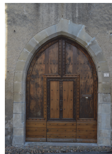
Portes cintrées à encadrement de pierres
