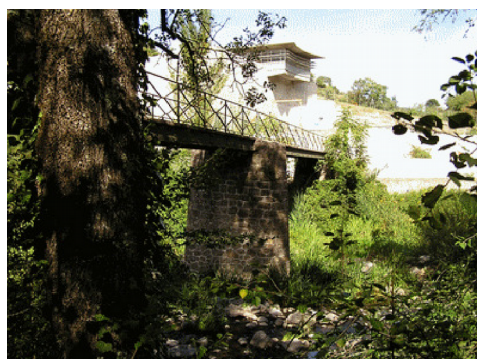
Passerelle de la STEP
