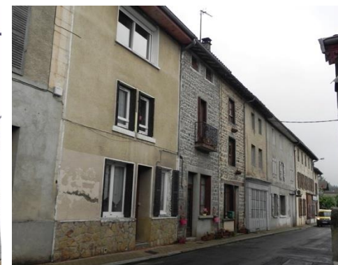
Ouroux : diversité de matériaux pour le revêtement des façades
