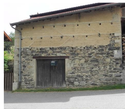
Saint-Christophe : bâtiment en pisé avec soubassement en pierre
