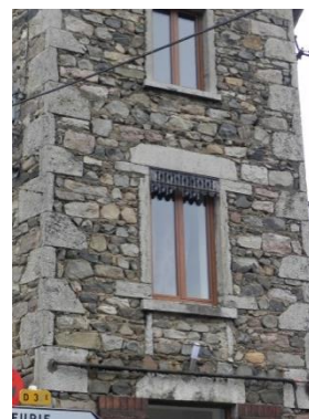
Ouroux : linteau en pierre granit
