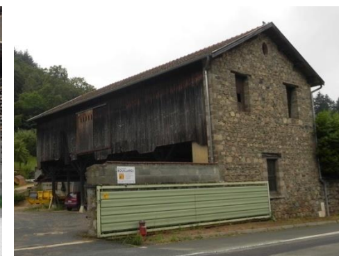
Ouroux : bâtiment agricole avec bardage en bois
