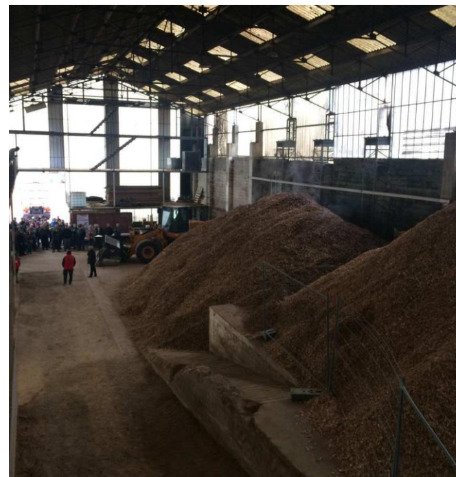
Plateforme bois-énergie de Saint-Igny de Vers
