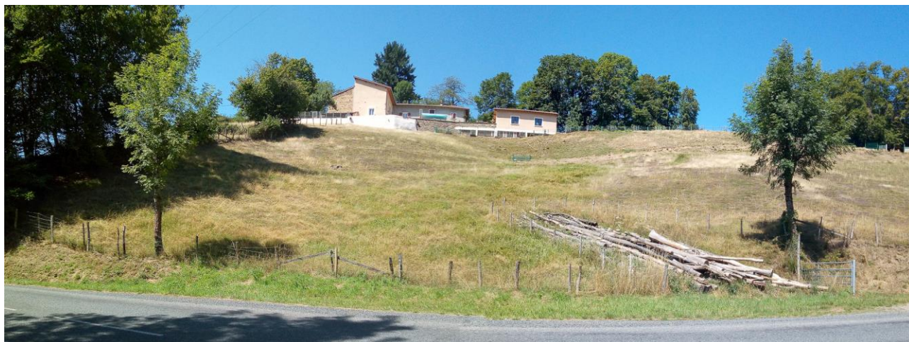
Saint-Igny-de-Vers : site du glissement de 2003. Photographie réalisée en 2019
