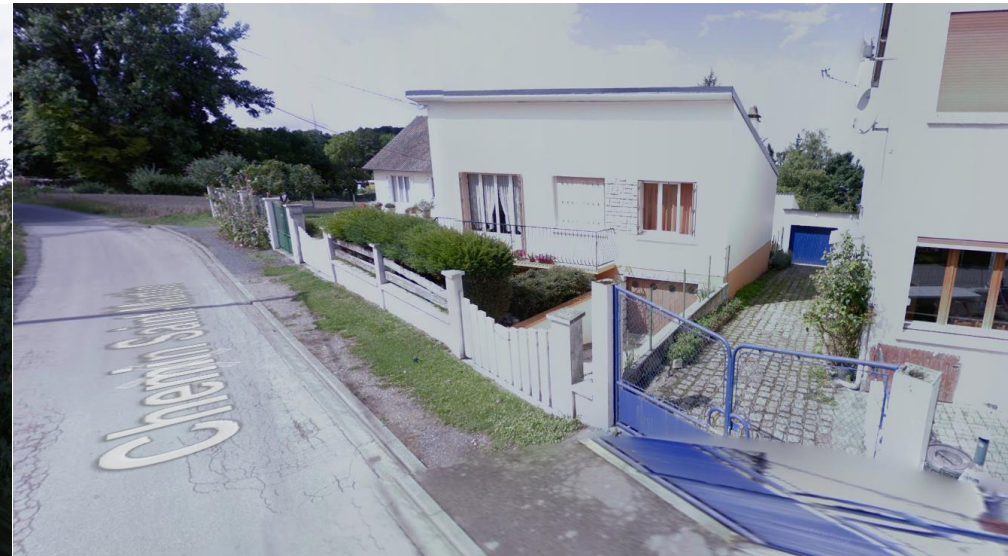
Habitations vulnérables en contrebas du chemin Saint Martin
