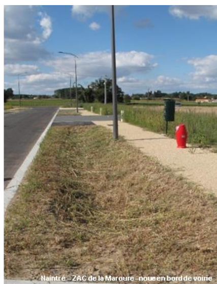
Figure 8 : Exemple de noue en bord de voirie
