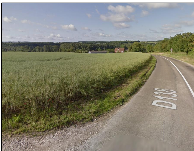
Figure 20 : Espace valorisable au droit de la RD138
