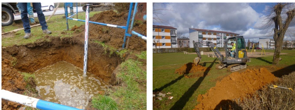
Figure 12 : Réalisation d'un essai d'infiltration
