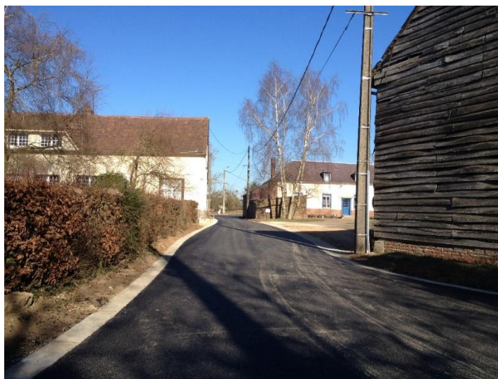
Figure 29 : Exemples de bordures non surélevées sur une voirie récente
