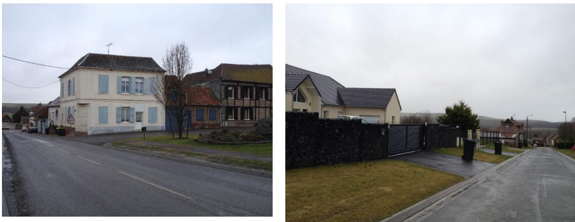
Figure 28 : Exemples de bordures de trottoirs et caniveaux en bord d'espaces verts
