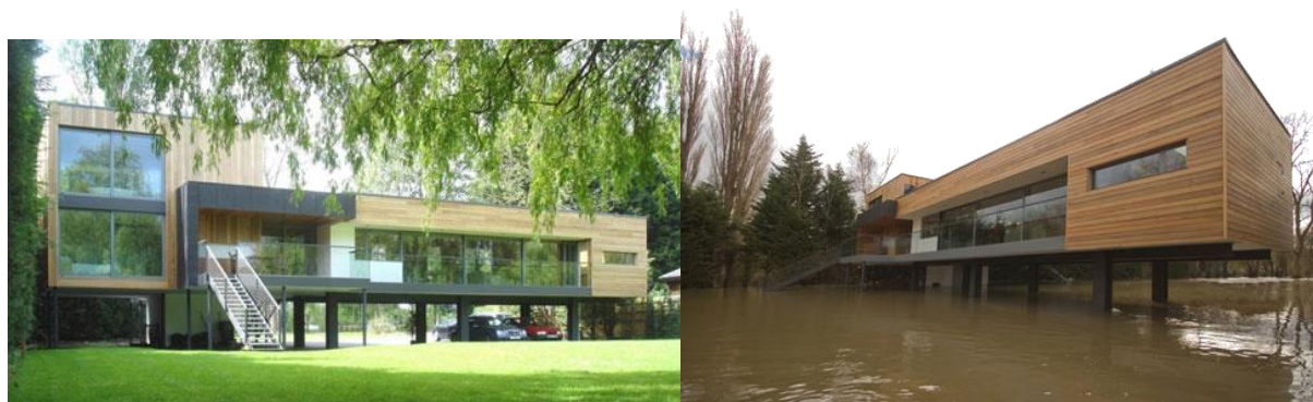
Figure 100 : Exemple d'adaptation de l'habitat au risque inondation dans un axe de ruissellement en Angleterre
