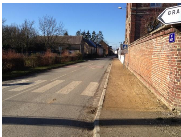
Figure 84 : Voirie amenant du ruissellement
