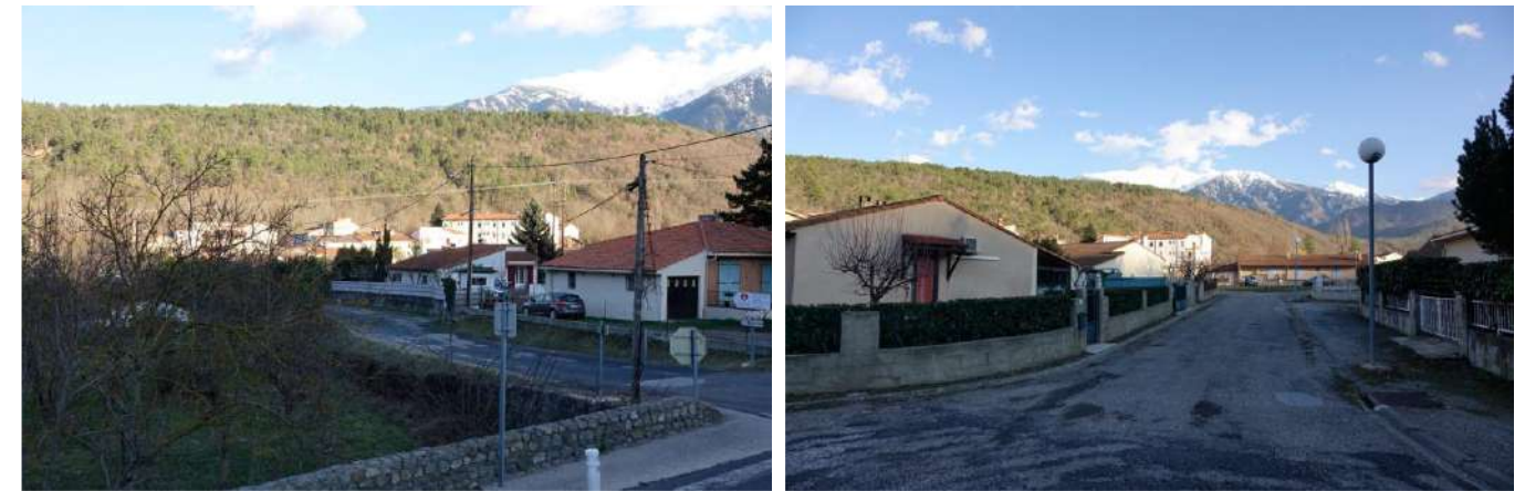
Etalement des maisons individuelles entre l'ancien chemin de Villefranche et la Départementale
