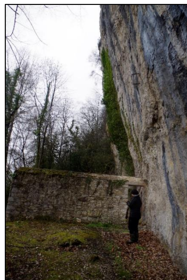
Photo 2 : Concession du Rancié – accès à la poudrière creusée dans la falaise (id. 9)
