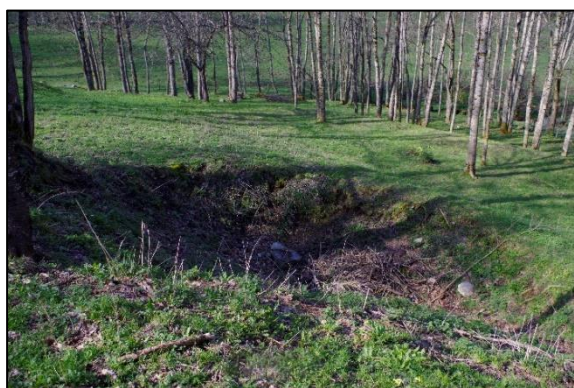
Photo 5 : Concession du Rancié – désordre sur la galerie Becquey (D6)
