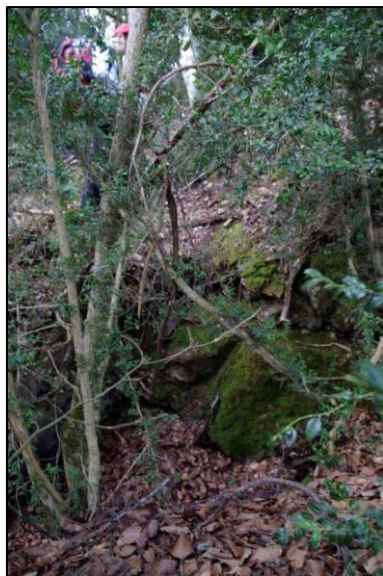
Photo 46 : Concession de Lercoul – entrée de galerie éboulée (id. 22)
