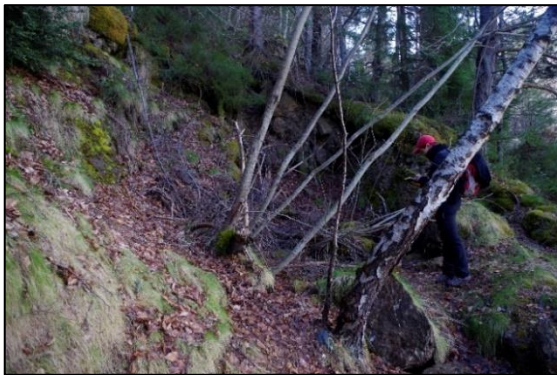
Photo 7 : Concession du Rancié – entrée de la galerie Bellagre éboulée (id. 11)
