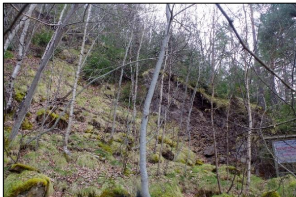
Photo 11 : Concession du Rancié – entrée de la galerie La Grailère éboulée (id. 3)
