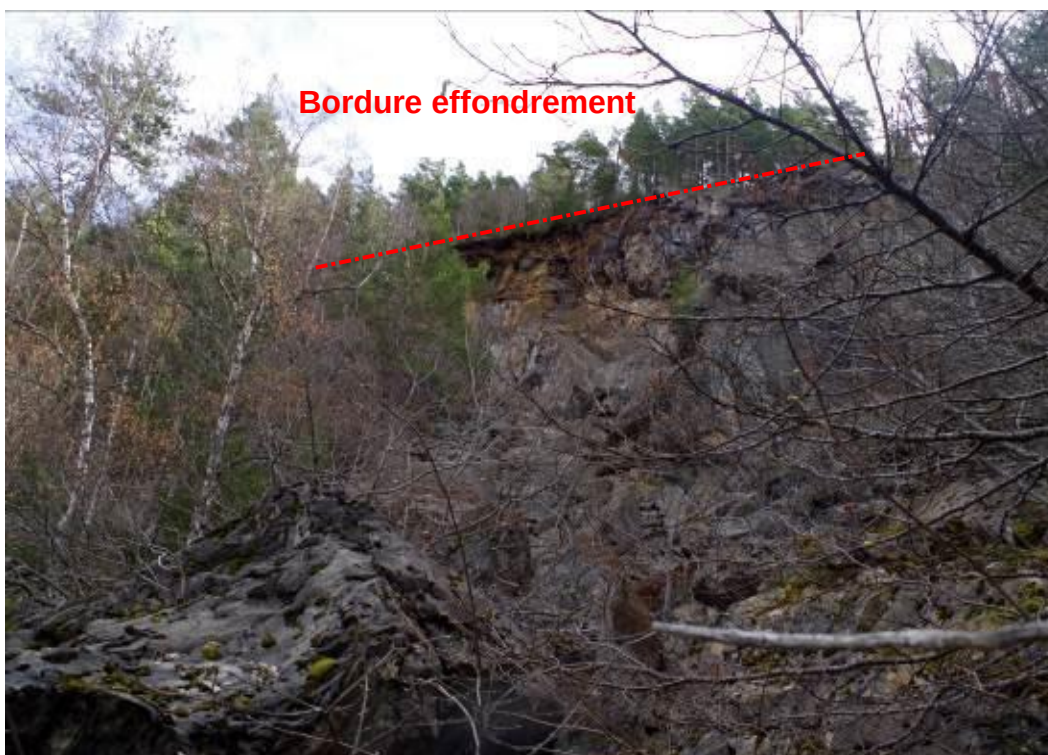
Photo 11 : Désordre de grande importance aval (effondrement de Becquet – D2)
