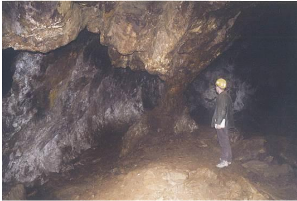
Photo 4 : Pilier aminci, probablement repris par les mineurs durant l'exploitation (Photo datant de 2001)
