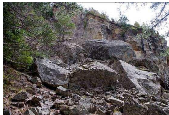
Photo 16 : Concession du Rancié – effondrement de grandes dimensions (D3) de la Craugne
