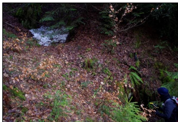
Photo 34 : Concession de Lercoul – entrée de la galerie Paul ouverte (id. 19) et désordre D14
