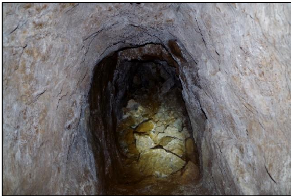
Photo 19 : Concession du Rancié – intérieur de la galerie Saint-Louis stoppée par un éboulement à environ 200 m de l'entrée (id. 15)
