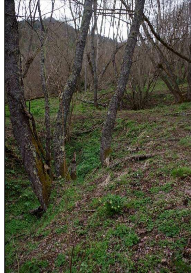
Photo 50 : Concession de Lercoul – désordres D15 et D16
