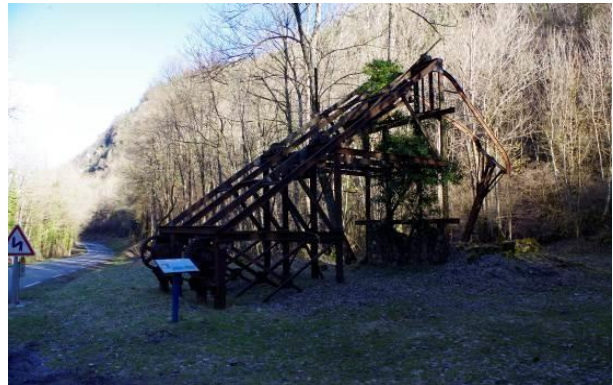
Photo 13 : Transporteur aérien en fond de vallée, en aval de la concession du Rancié et prolongement de la trémie
