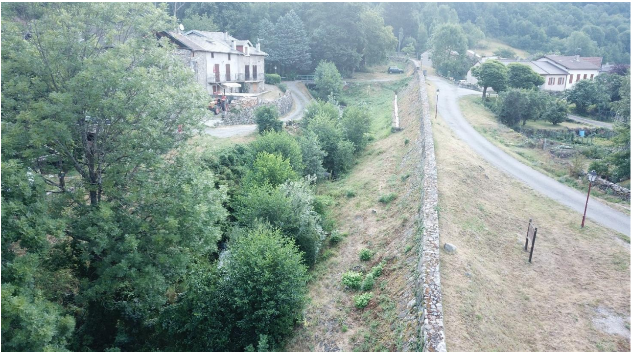
Figure 25 : Photographie d'une partie du système d'endiguement de Verdun (source : ETRM, 2022)
