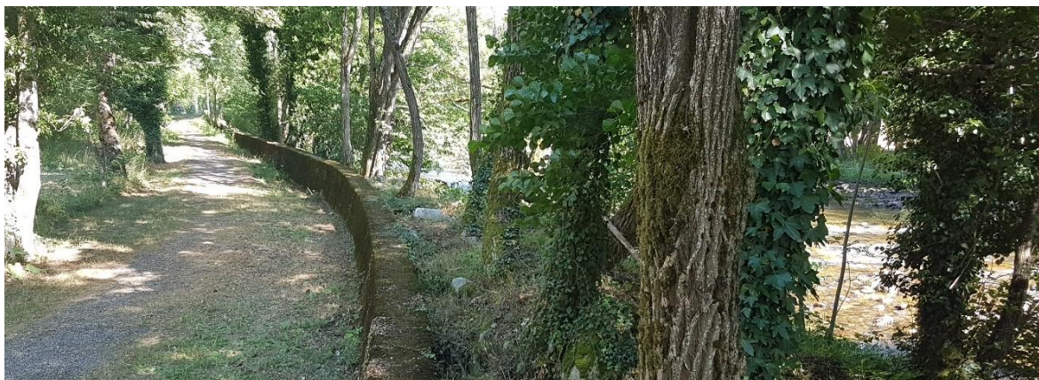
Figure 22 : Photographie d'une partie du système d'endiguement de Savignac-les-Ormeaux
