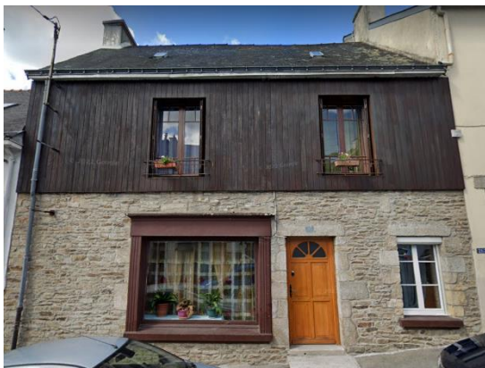
Surélévation traditionnelle en bois source : Google street view)
