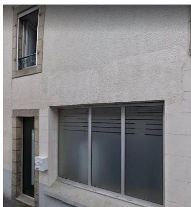
Le percement des nouvelles ouvertures non adaptées aux proportions des fenêtres existantes (source google street-view)
