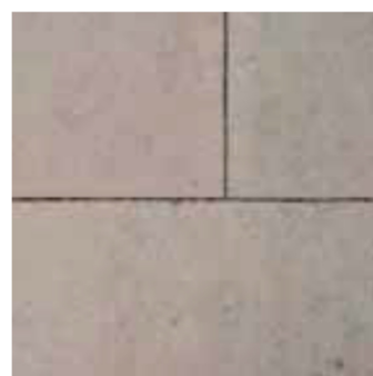
Pavé en grès : Matériau imperméable ou perméable. Possibilité de rendre la surface revêtue perméable par l'utilisation de joints perméables
