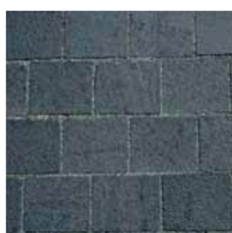
Pavé en dalles de granit : Matériau imperméable ou perméable. Possibilité de rendre la surface revêtue perméable par l'utilisation de joints perméables
