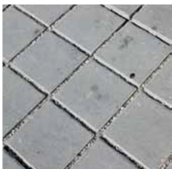
Pavé en béton poreux
