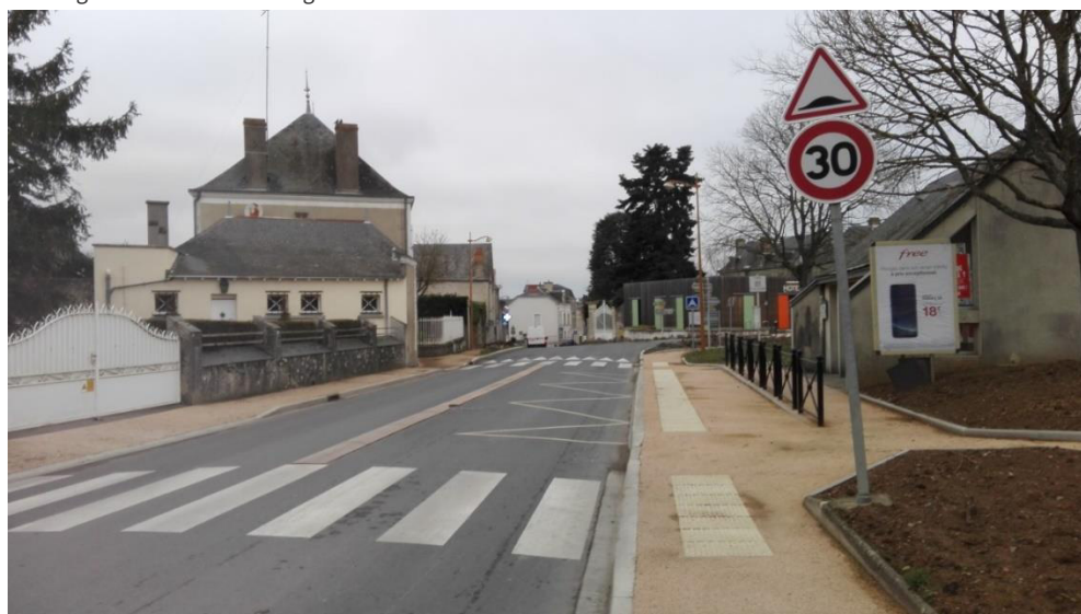
Aménagement du centre-bourg de Saint-Varent en zone 30
