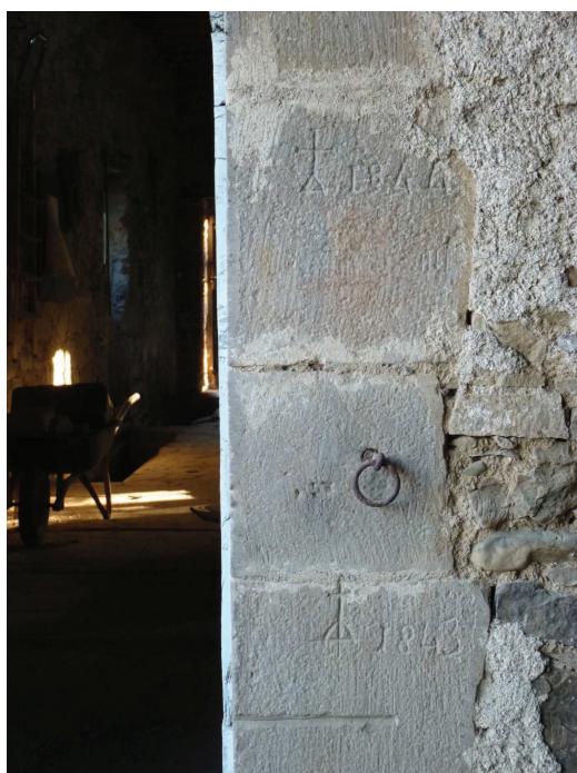
Figure 10 : Moulin de Cabrol (Réalmont) : repères gravés des crues de 1843 et 1844. Le niveau de la crue de 1930 est intermédiaire.
