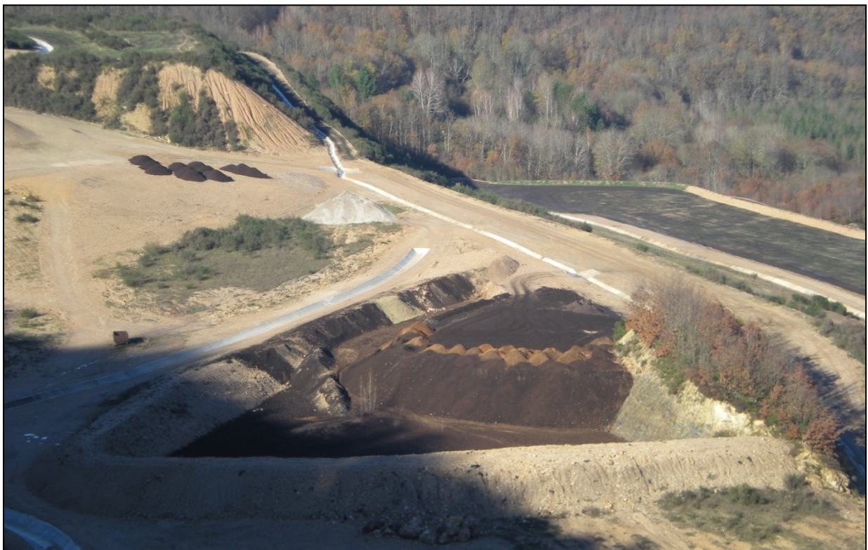
Vue générale du site de stockage des boues au Moulinal (cliché MINELIS du 01/12/2015)
