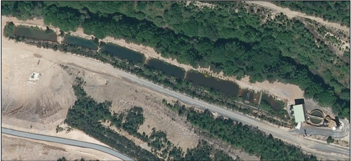
Figure 7 : Vue aérienne de la station du Moulinval et ses lagunes
