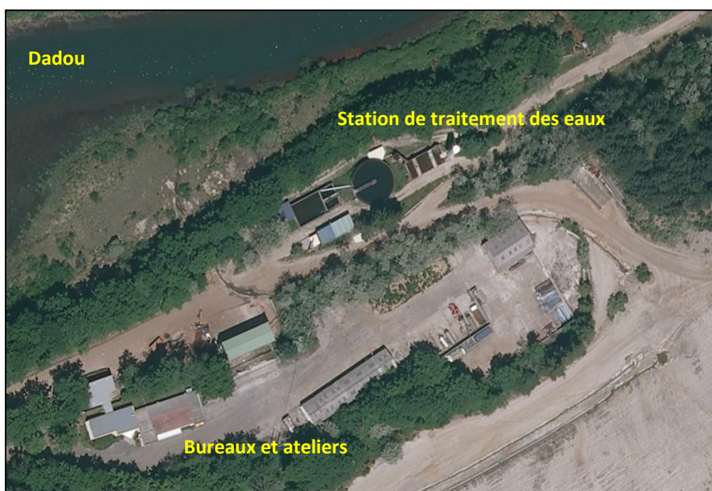
Figure 9 : Vue aérienne de la station de traitement de Mont-Roc
