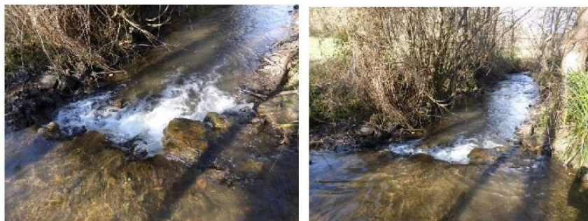
Gué du cimetière (seuil en rivière) au lieu-dit « La Crouzette » sur le ruisseau de Malagousse (commune de Curvalle) ©ECTARE
