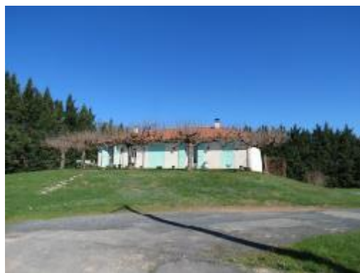
Construction neuve Al Cun (Mouzieys-Teulet) Couleur menuiseries
