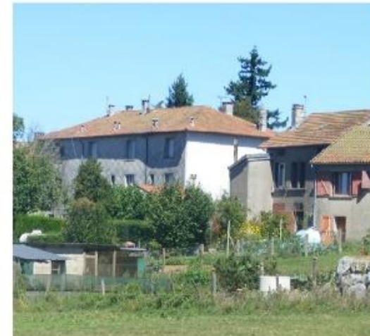
Maisons du centre bourg, créant la rue et s'ouvrant sur le vallon jardiné et cultivé
