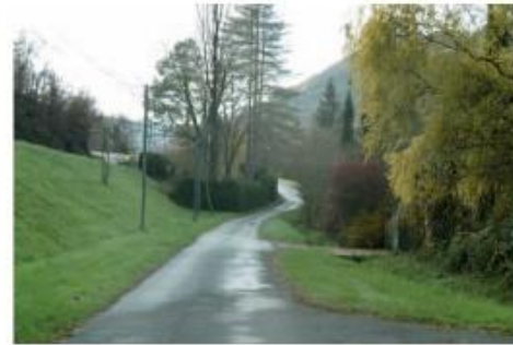
Voie de desserte du vieux village le long de la digue.
