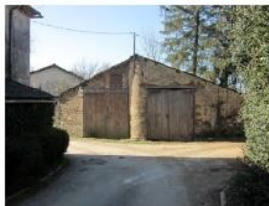
Hangar double: forme adaptée à des usages peut-être mutualisés
