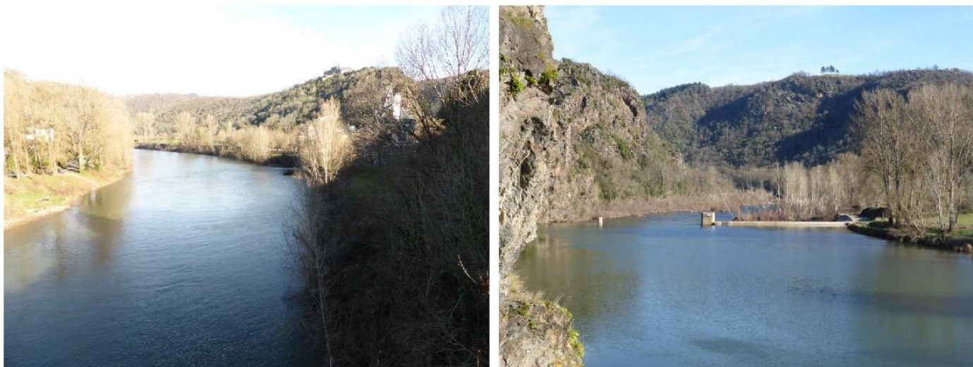
Usine hydroélectrique d'Ambialet sur le Tarn ©ECTARE
