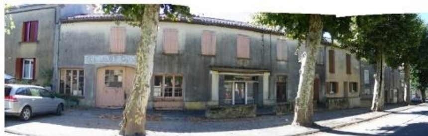
Alignement du bâti côté
