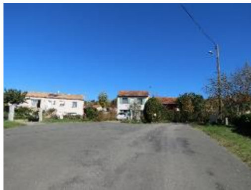
Lotissement La Grange Basse (Villefranche d'A.) Délaié de voirie
