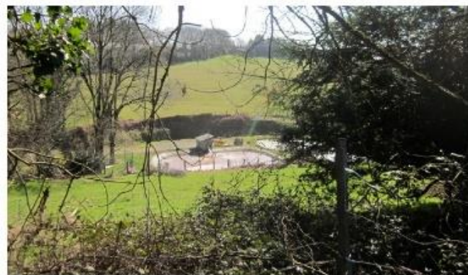
Station d'épuration en fond de cirque, point de vue central depuis le village (3)
