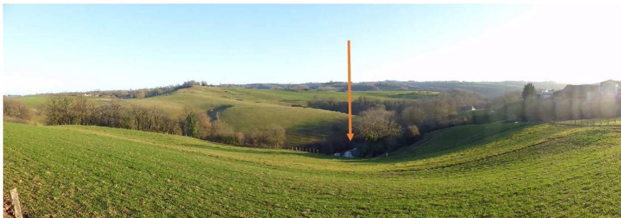
Retenue collinaire sur l'Assou au lieu-dit « La Fourmie » (commune de Villefranche-d'Albigeois) ©ECTARE
