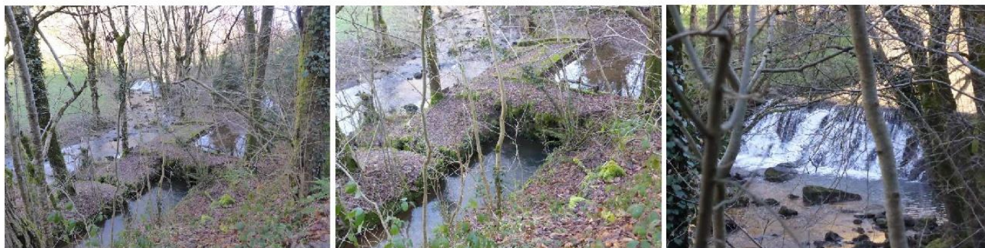
Seuil en rivière en amont d'une pisciculture sur le Dadounet au lieu-dit « Les Cabanes » (commune de Mont-Roc) ©ECTARE
