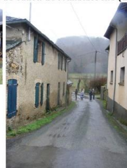
Ruelle et pont de l'Ambiasselle Vue Ouest Est (4)
