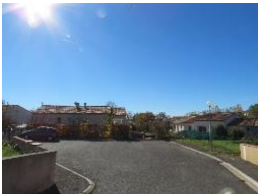
Lotissement La Grange Haute (Villefranche d'A.) Voirie en impasse
