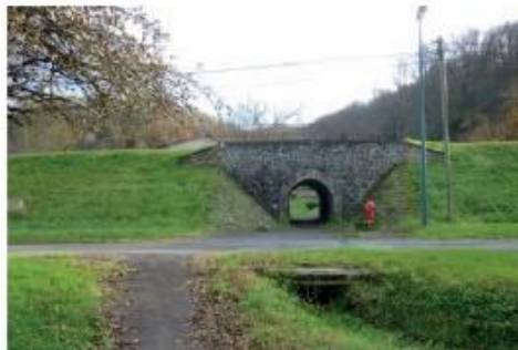
Ouvrage de franchissement de la digue destiné au passage des écoulements.
