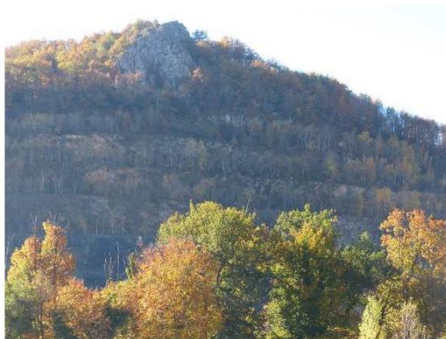
Illustration 38 : Zoom sur le front réaménagé de la carrière de Mont-Roc ©ECTARE
