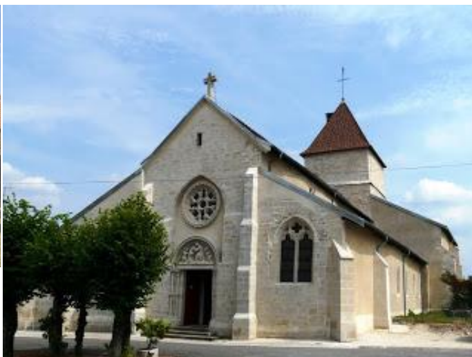
Eglise de la Nativité à Gondrecourt-le-Château
